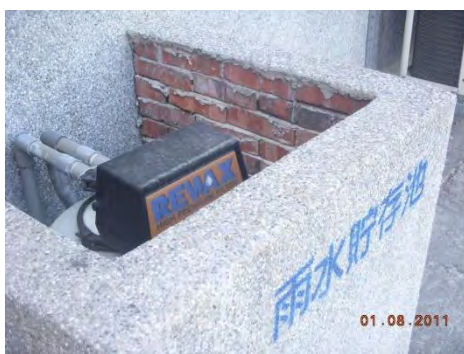
圖 5-13 雨水回收系統
