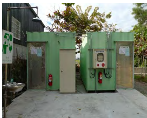
圖 7-13 實驗室廢液暫存間(外部)
