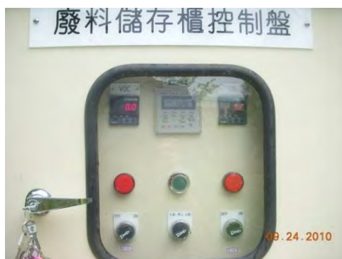
圖 7-11 偵測器與通風控制盤
